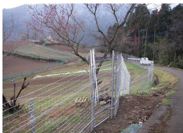
広域防護柵設置
