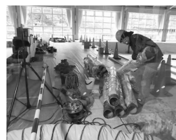
プール吐出配管改修工事 (教育費)
