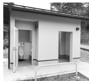
金沢観光トイレ建築工事 (商工費)
