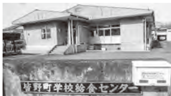
昭和54年建設の給食センター
