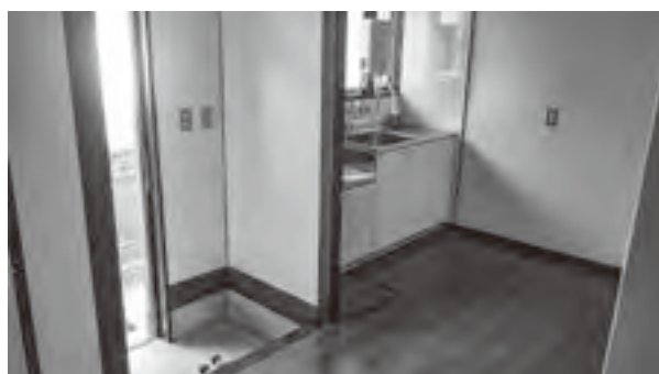
改修された町営住宅
