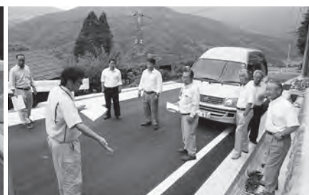
地滑り区域のため、施工に配慮した 町道三沢66号線
