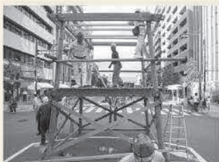
2時間30分という短時間で櫓を設置。時間との闘いでしたが、無事完了。
