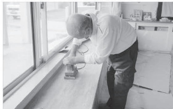
皆野幼稚園 棚天板補修
