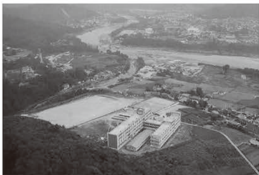
写真・左側の校舎と通路のみでスタート。 右側の校舎(産振棟)完成直後に撮影(昭和47年撮影)
