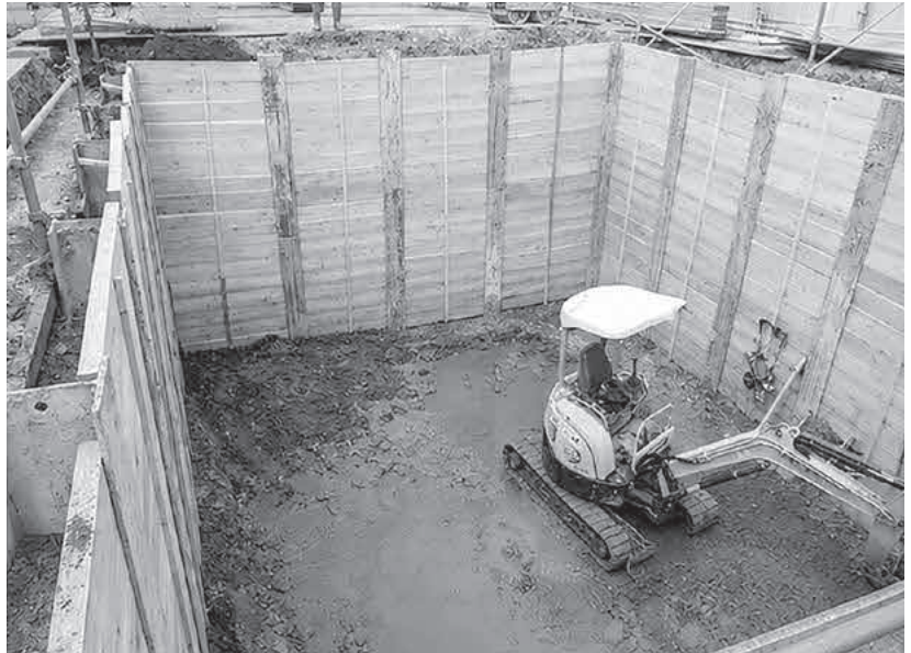
排水処理槽整備が進む工事
